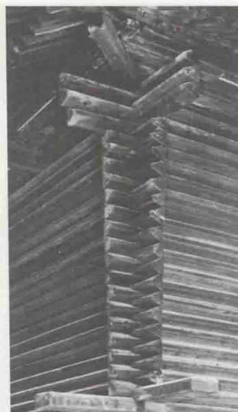
校倉 正倉院宝庫南倉 南西隅。三角形断面の 校木各20本を交互に組 み、積みあげている。 この校木の組んだ鼻先 の出は、下から上へい くにつれ、徐々に伸び ている
