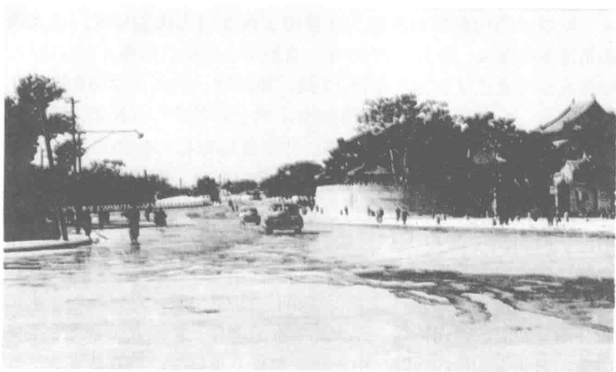
北海大桥 S 形弯道处
