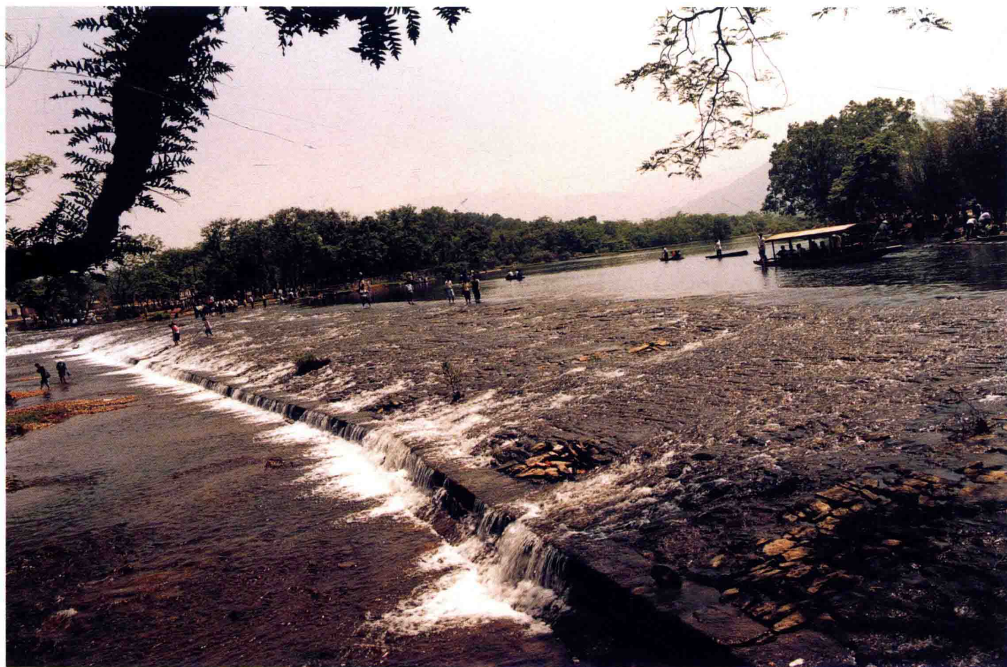
灵渠小天平坝泄水现状
