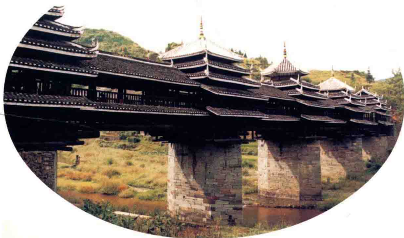
程阳永济桥近景
