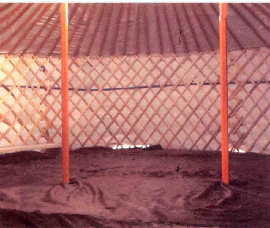
搭建完成后的蒙古包内部
