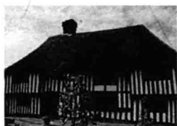
(c) 露出明木骨架的建筑 (德国)
