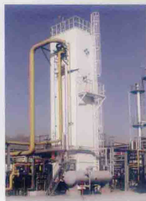
磴口30m³/d LNG装置
