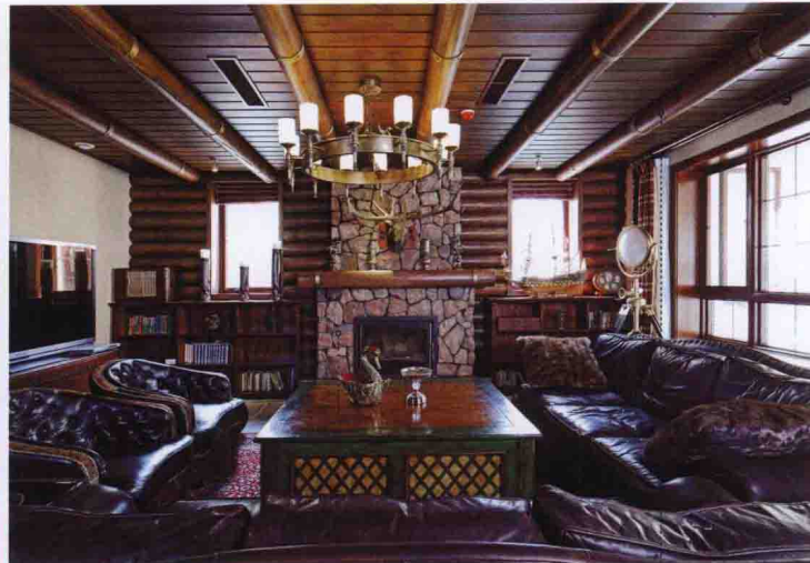
文化石铺贴壁炉
