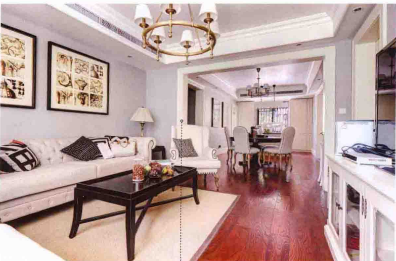
木饰面垭口混漆刷白
