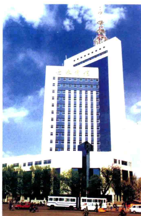
长春电信枢纽大楼
