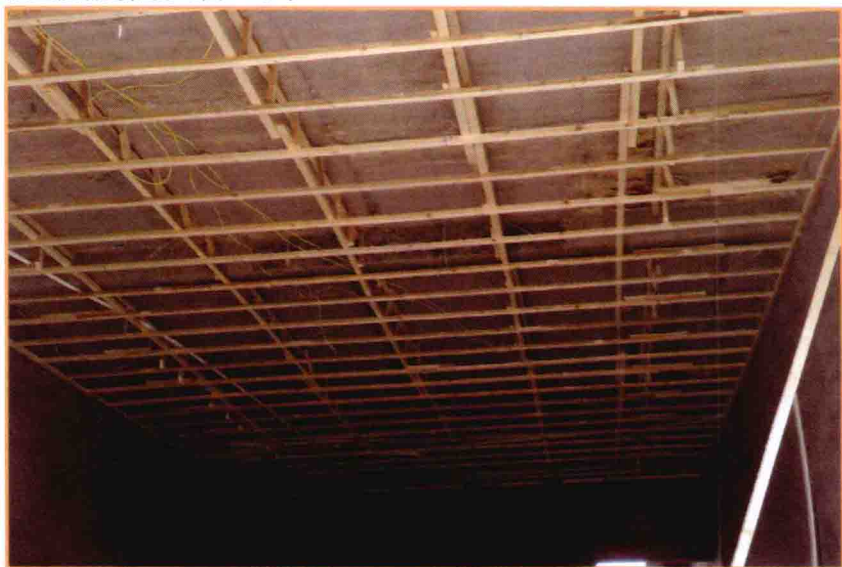
图1-1 卧室木龙骨吊顶
