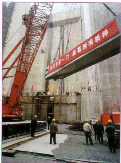
永久船闸第一扇闸门吊装
