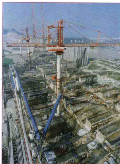
混凝土浇筑刷新世界纪录
