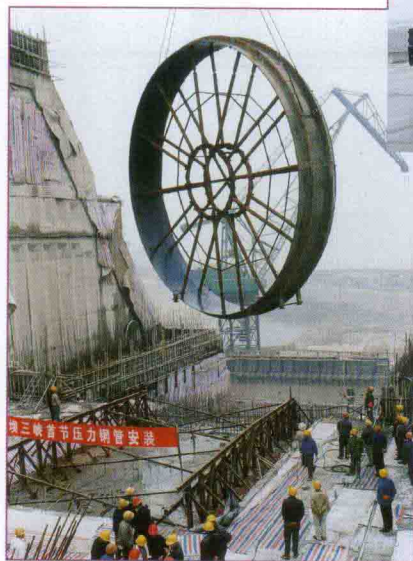
首节压力钢管安装
