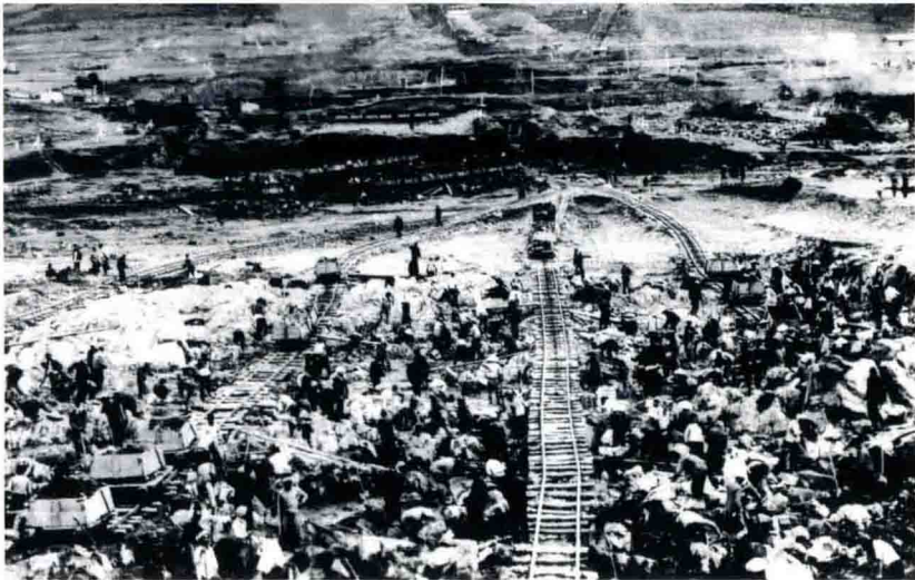
日伪统治时期先后有 10 余万劳工修建丰满水电站。
