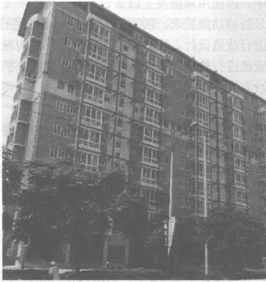
图 1.1-15 已建成的济南埃菲尔花园钢结构住宅楼
