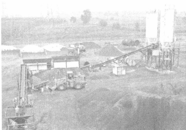
图 1.6 厂拌冷再生混合料破碎、筛分及拌和
