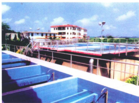
南洋自来水公司水厂（照片由澄海南洋自来水公司提供）
