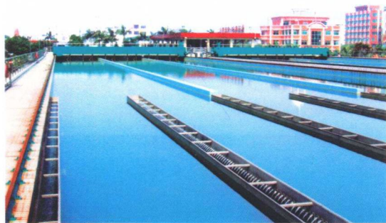
澄海市自来水公司第二水厂(沈立仁摄)
