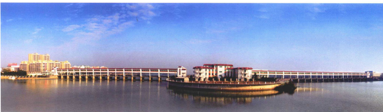
重建的外砂桥闸（照片由澄海市水利局提供）
