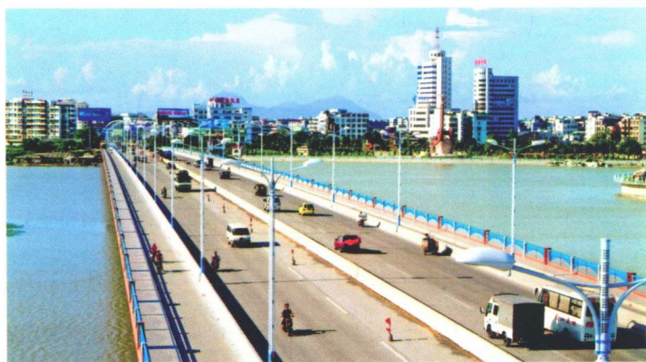
新建外砂大桥（陈 志伟摄）
