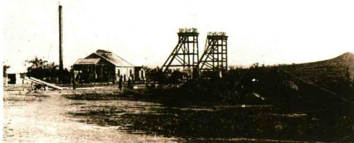
北洋滦州官矿公司用土法开采的陈家岭附矿桃园副井
