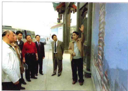
作者視察眉山遠景樓建設工地
