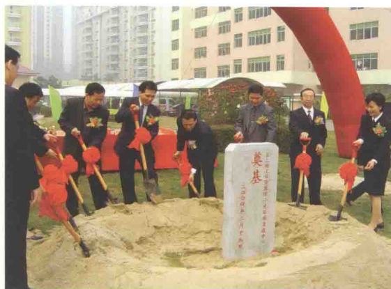
二期工程妇儿康复大楼奠基仪式
