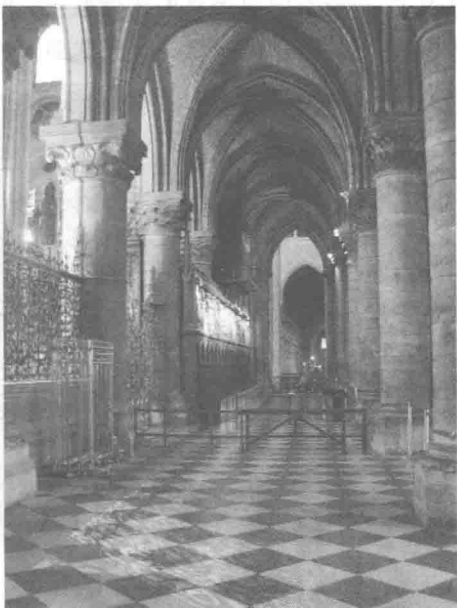
图 1-7 骨架券结构体系
