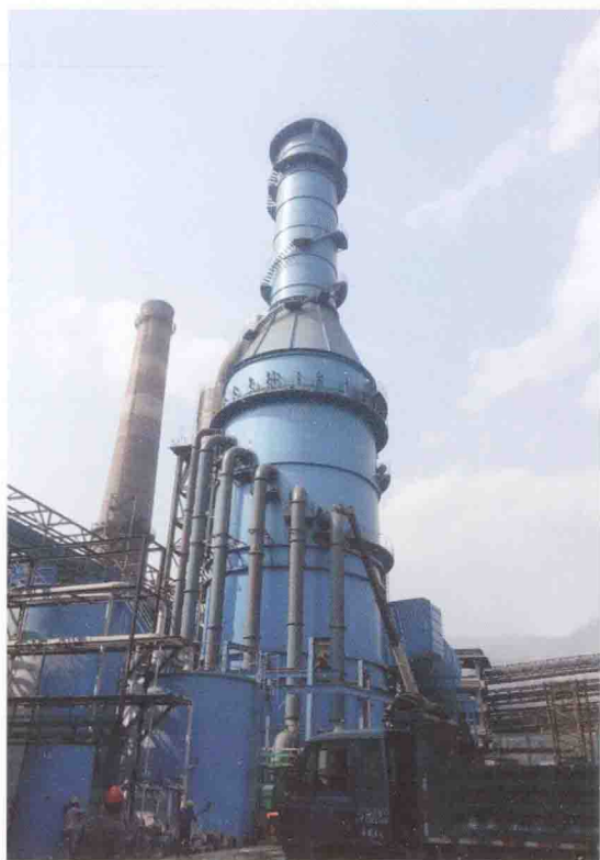
攀钢钒 360m 2 烧结机石灰石 - 石膏法脱硫 (在建)
