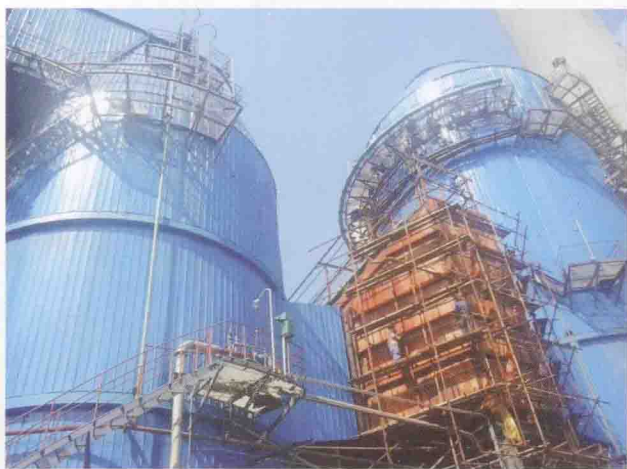
武钢 435m 2 烧结机氨法脱硫 (在建)
