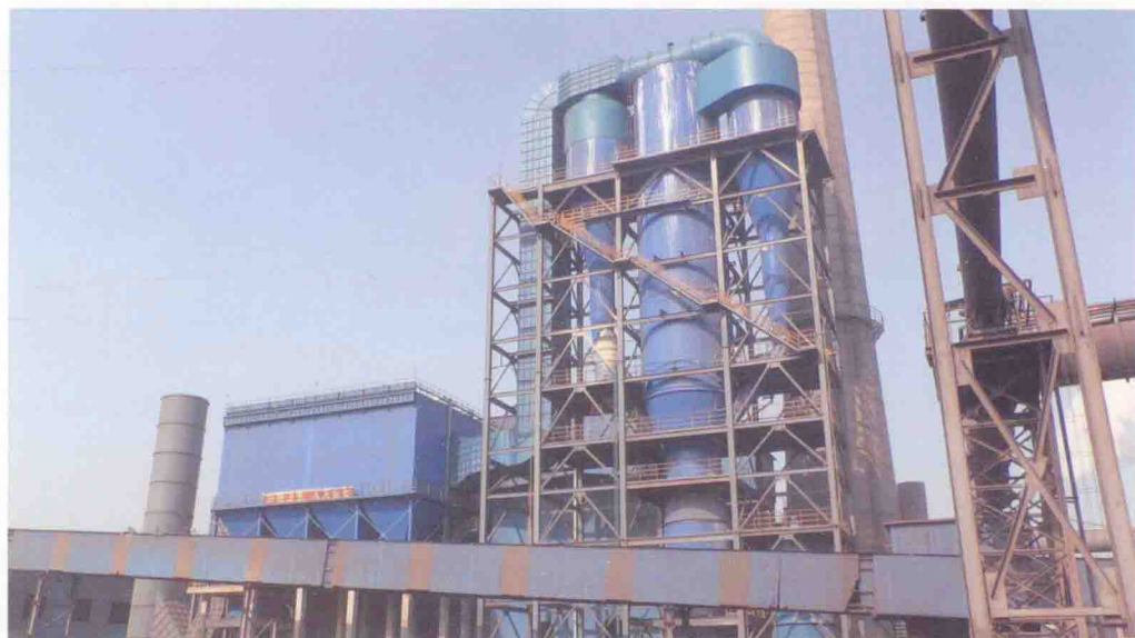
徐州成日钢铁 132m 2 烧结机 IOCFB 法多污染物协同控制
