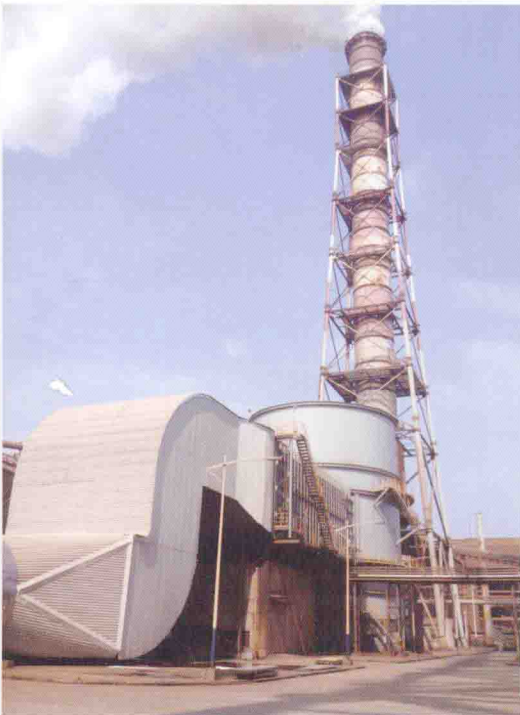
宝钢 495m 2 烧结机石灰石 - 石膏法脱硫
