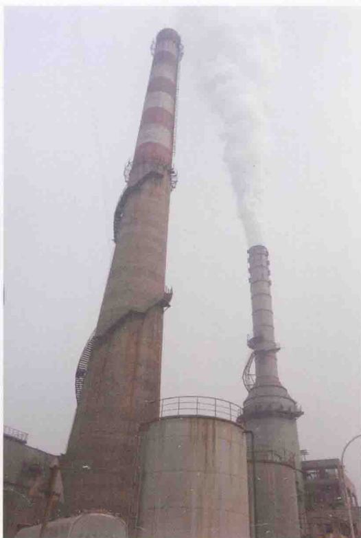
攀成钢 210m 2 烧结机氨法脱硫
