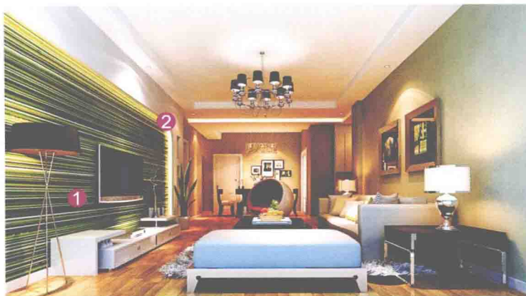
① 墙纸 ② 石膏板造型暗藏灯槽
