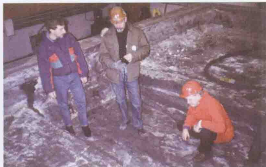
图6-5 电解槽解剖过程中清理出的正准备检查的第一条深入阴极的沟槽
