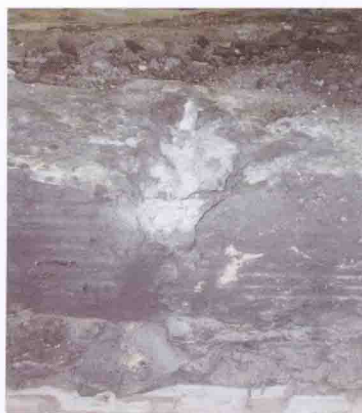
图6-9 因一个底部炭块产生热冲击裂缝而导致的电解槽破损。随着时间的推移，断裂区域的电流密度增加导致严重的局部腐蚀，槽寿命1119d
