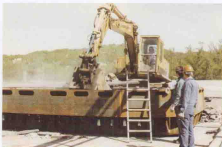
(b) 利用反铲挖掘机清除大部分的碎块
