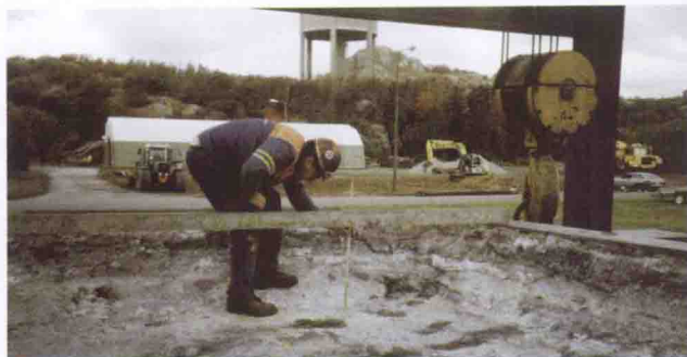
图6-2 清理干净电解槽槽膛测量
