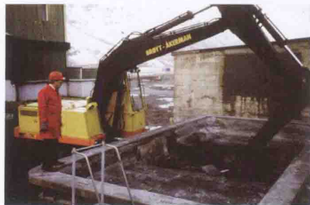
(a) 液压锤通过反铲挖开阴极炭块的边部框架
