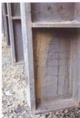
图6-53 应力通过在铁锈覆盖物上产生裂缝来释放，这表明在刚性阴极支撑结构中的应力已经超过了钢梁的屈服强度
