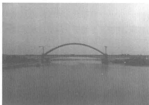
图 1.1-3 莞惠城际铁路东莞水道桥
