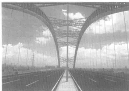
图 1.1-2 广州丫髻沙大桥
