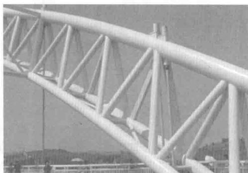
图 1.1-1 贵阳花溪大桥的拱肋结构
