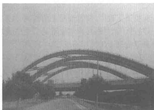
图 1.1-4 郑焦城际铁路跨黄河大堤桥
