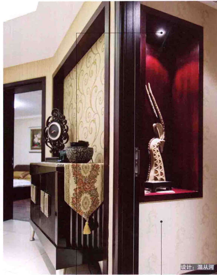
木基层板开孔，内镶2寸 / 2.5寸筒灯 艺术壁纸
