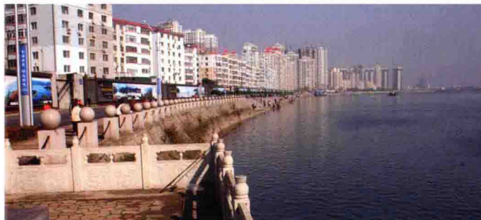
丹东市鸭绿江防洪护岸工程
