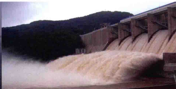
凤城市土门水库除险加固工程
