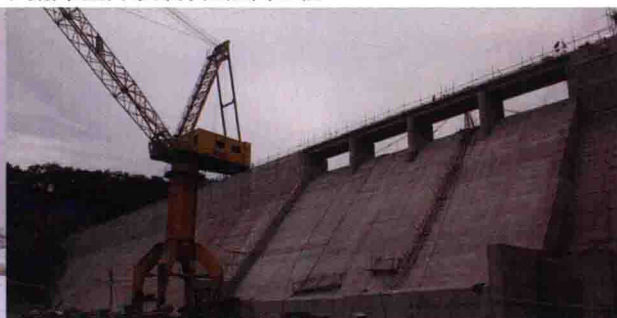
天桥沟水利枢纽工程
