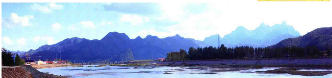
凤城市草河河道治理工程
