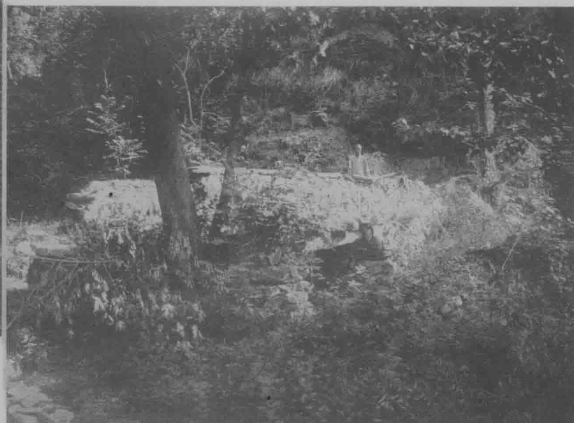
(16) Ting Fan Bridge
