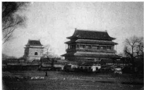
昔日钟楼（后）鼓楼（前）
