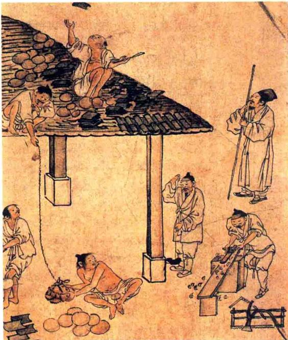
《建房上瓦》，建房的工人们有条不紊地紧张配合着。房顶的瓦工利用空闲休息，将瓦片高高抛起，似乎在耍杂技。旁边的主人拄杖观看，脸上带着微笑。右侧下方，一个人拿着墨斗测量精度，木工则在刷刷地裁着木头。
