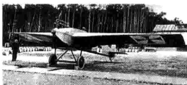
图1.2.4 世界上第一架全金属单翼机
