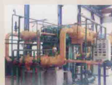
往复式氮气压缩机组
