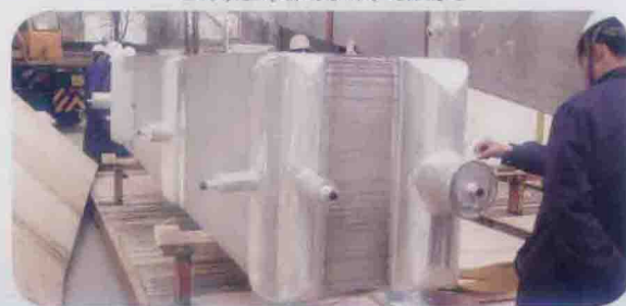
替换中石油兰化原进口高压主换热器
