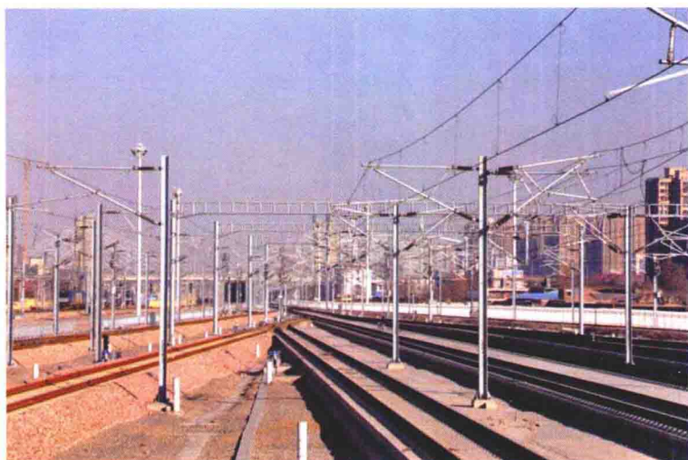
枢纽接触网工程
