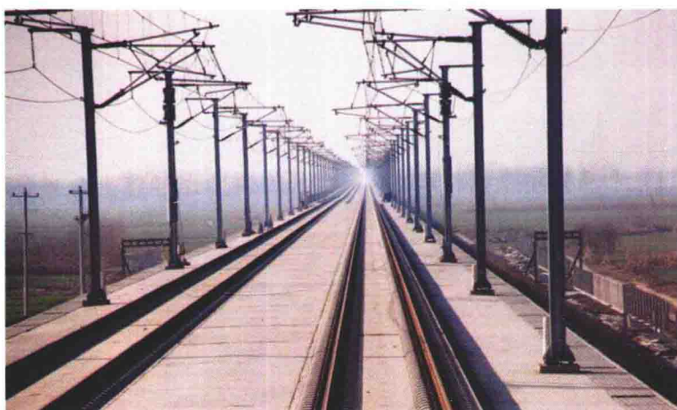
区间接触网工程
