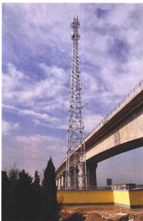
杜家坎通信铁塔是全线 最高铁塔,塔高 75 m
