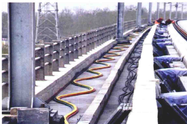
区间电缆布放“蛇”字形排列
