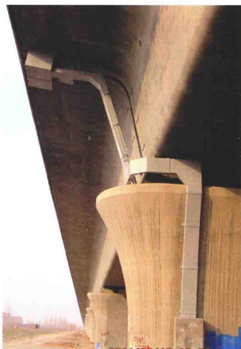
光缆上桥采用喷塑槽道
