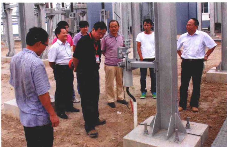
京石公司副总经理毛秉仁(左二)在大刘庄牵引变电所检查工程质量
