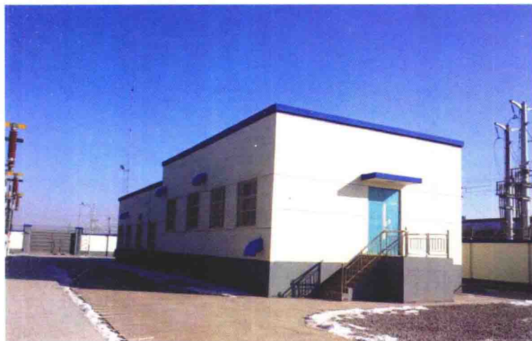
新安牵引变电所房屋
