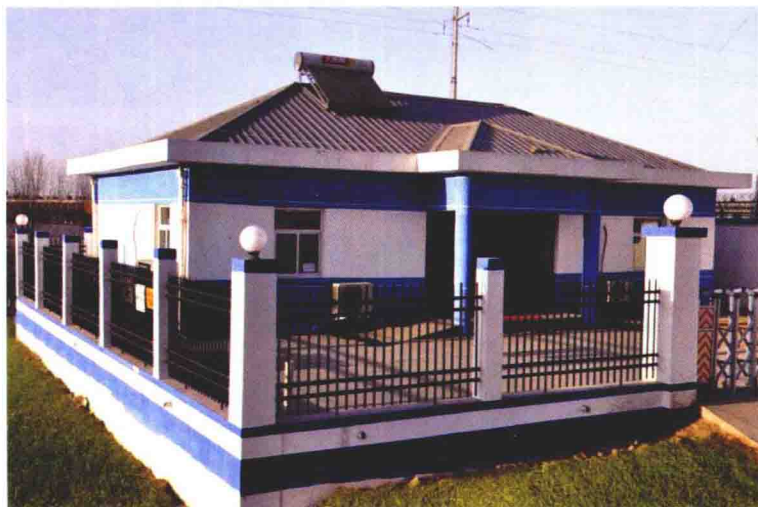
区间公安警务工作区房屋
