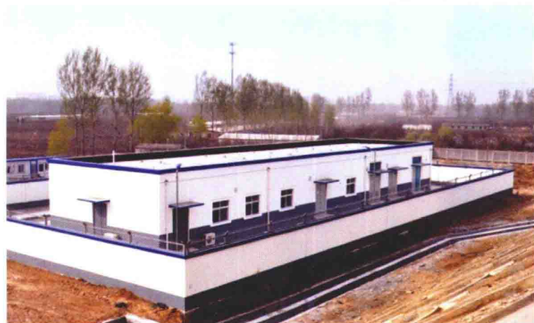
涿州东 10 kV 配电所全貌
