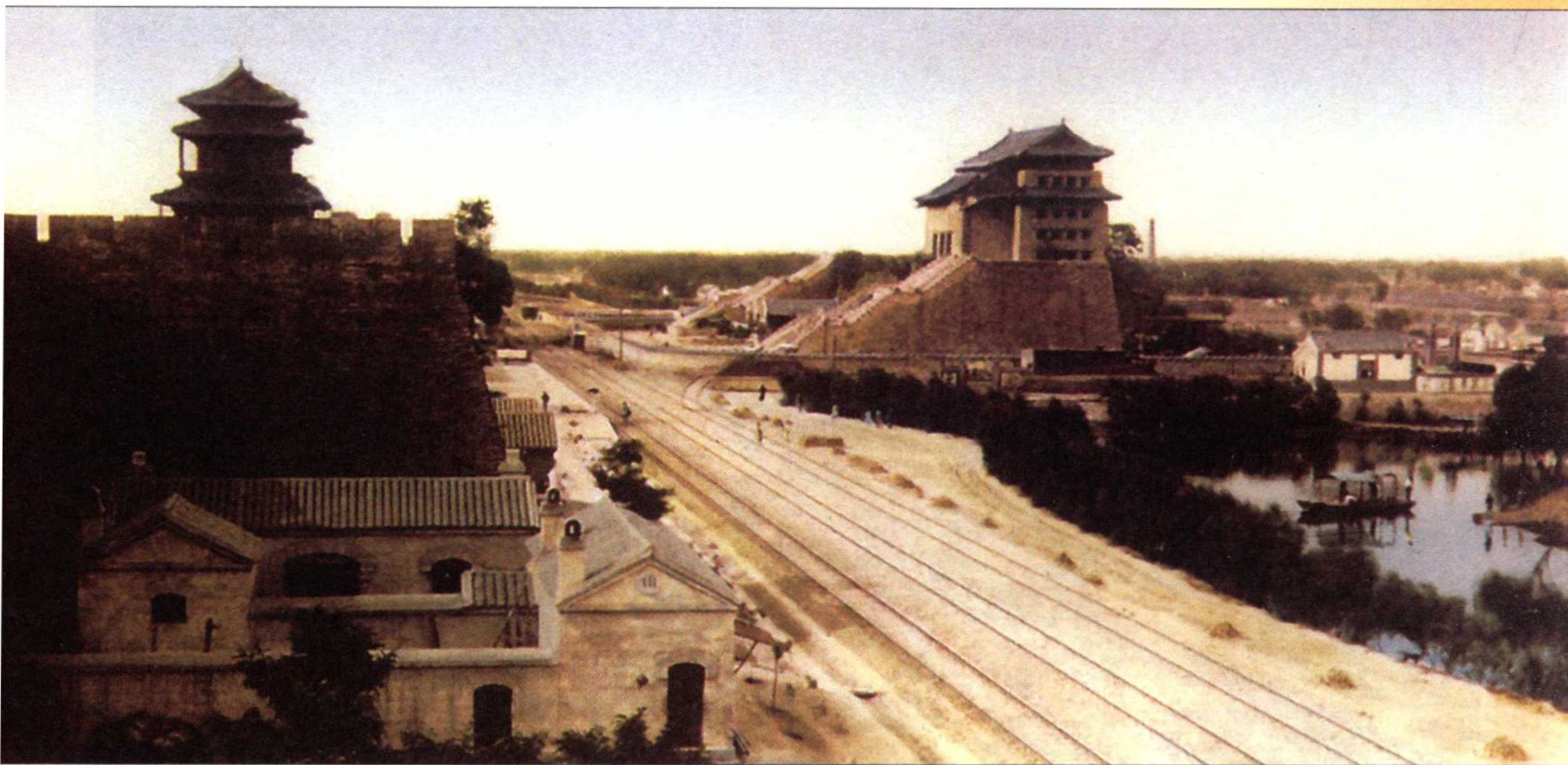
朝阳门城楼和箭楼
