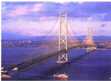
图0.13 日本明石海峡桥
