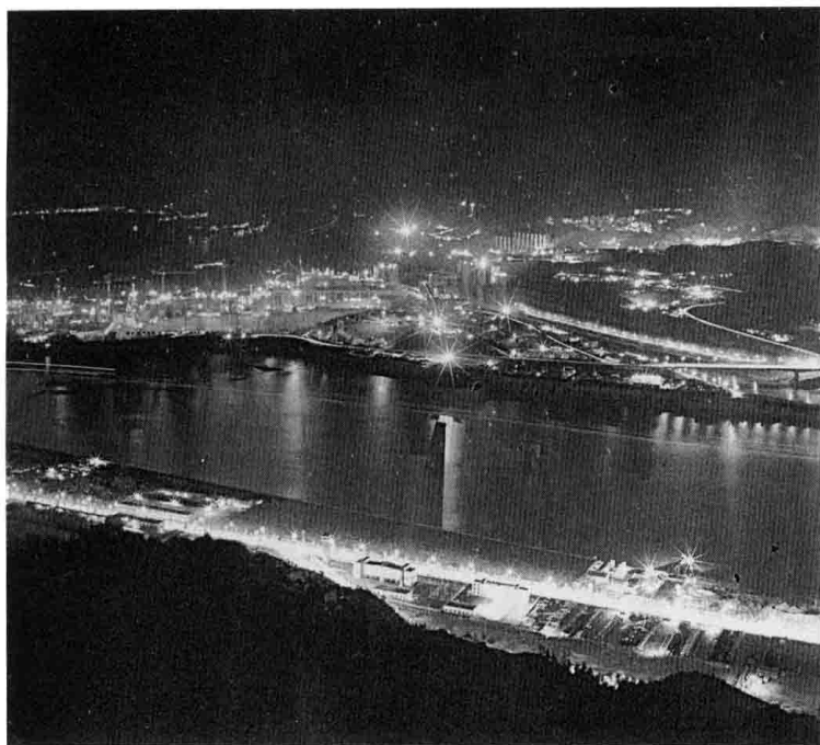
三峡工程第一阶段的建设任务全面完成，百万大移民工作进展顺利。全体三峡建设者和三峡人民正按党中央国务院的要求“为我中华，志建三峡”。三峡库区的面貌焕然一新。图为灯火辉煌的三峡工地。（2000年）
