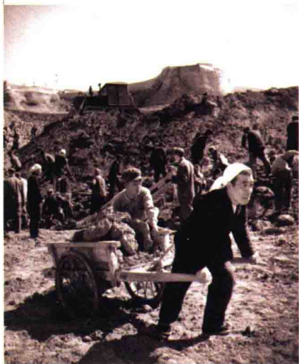
图1-4 在搬山填沟造平原工地，陈永贵带头劳动
