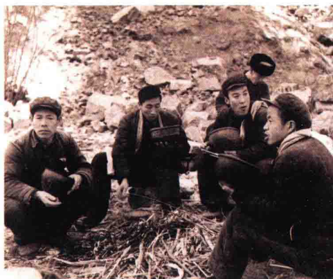
图1-2 冬天，在治山治沟工地，人们吃着“冰渣饭”
