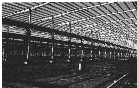
图 0-4 轻型工业厂房门式刚架
