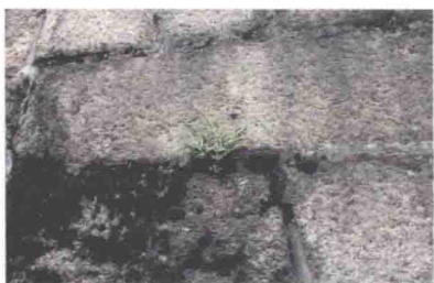
谯楼花岗岩石基
