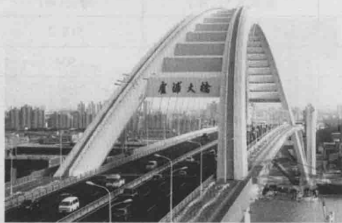
图1-1-5 上海卢浦大桥
