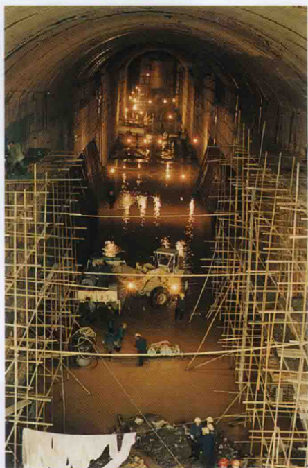
导流洞施工
