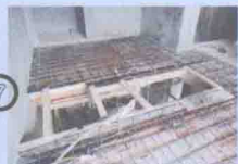
图1-67 钢筋架设楼板
