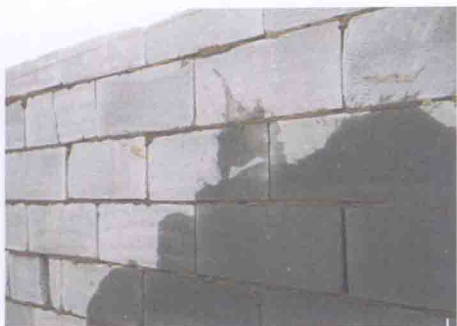
图1-17 粉煤灰砌块墙体
