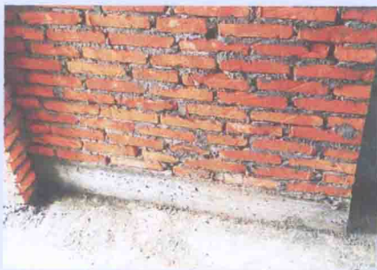
图1-4 黏土砖砌筑墙体
