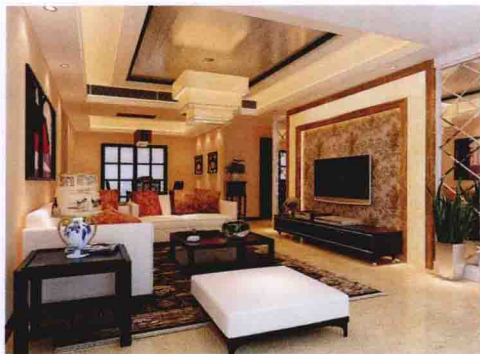
顶面 [石膏板造型 + 墙纸 + 木线条收口]
