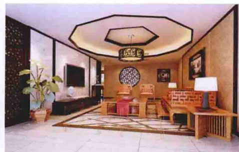
顶面 [石膏板造型 + 木线条压边]
