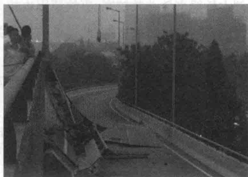
图 1-3 钱江三桥引桥垮塌事故
