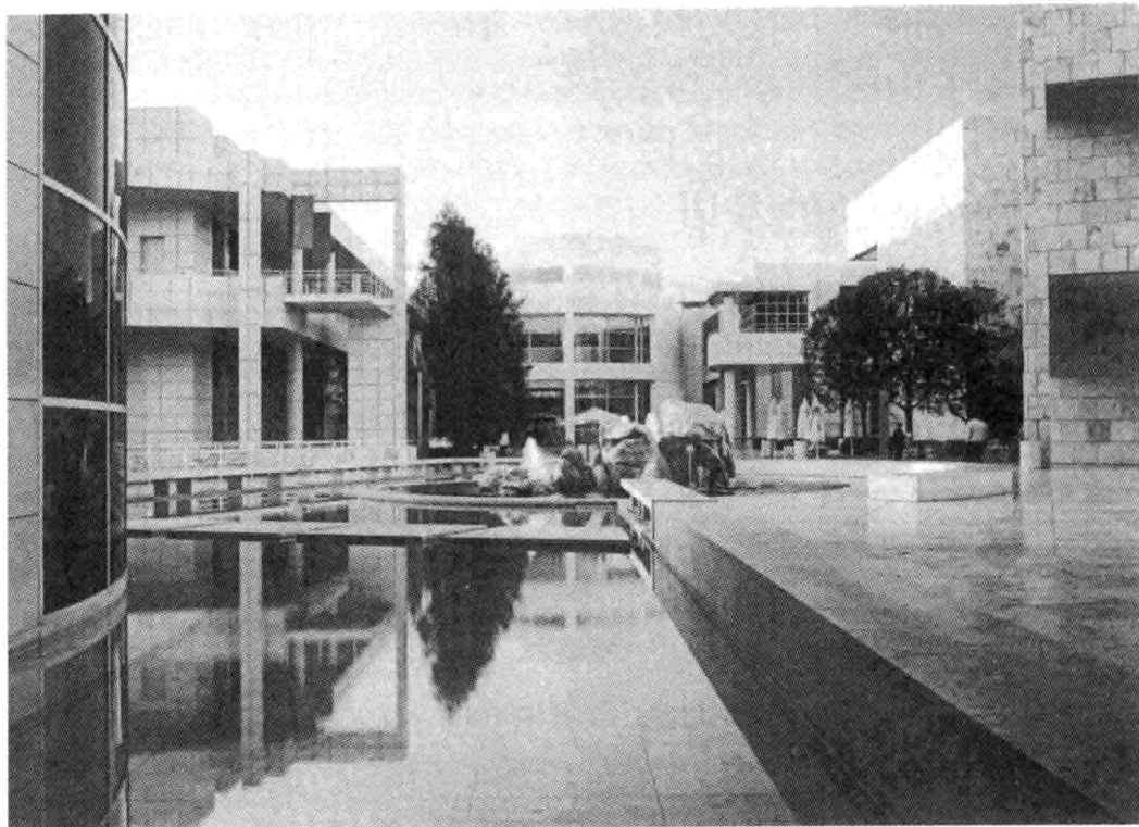
图1-8 这是圣·保罗·盖蒂中心（J. Paul Getty Center）区的众多花园之一。所有花园都是建在车库、运输和接待设施、机械间、储藏间和部分图书馆和研究中心上面。
