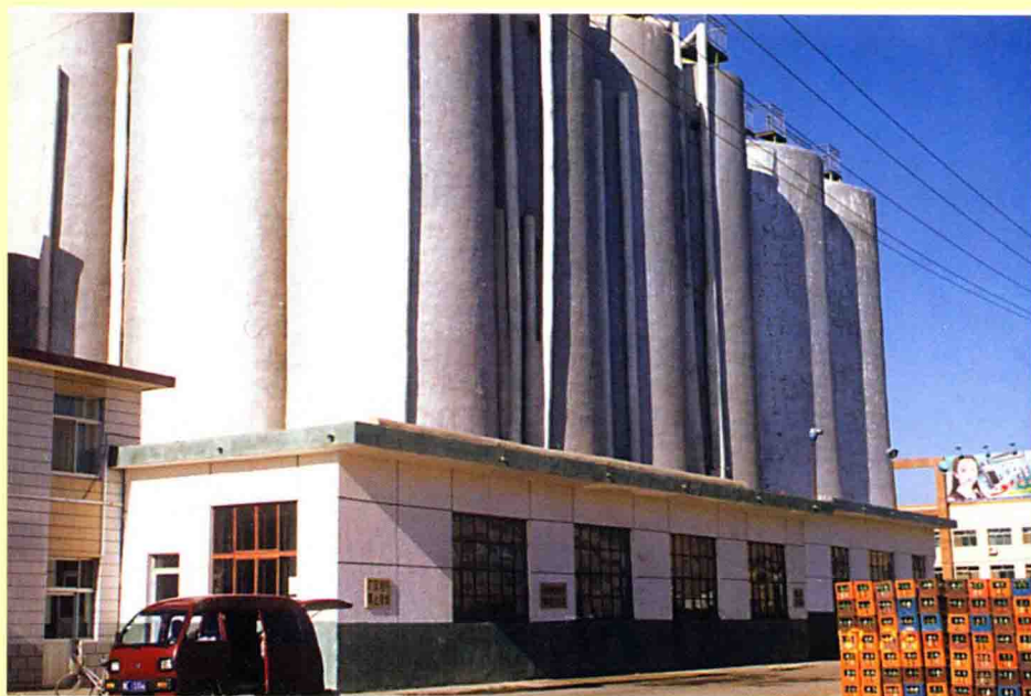
● 金川保健啤酒露天发酵大罐
