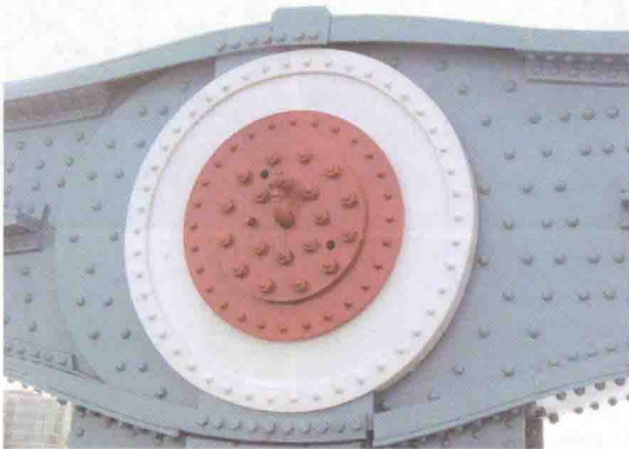
◆ 外侧段钢结构
