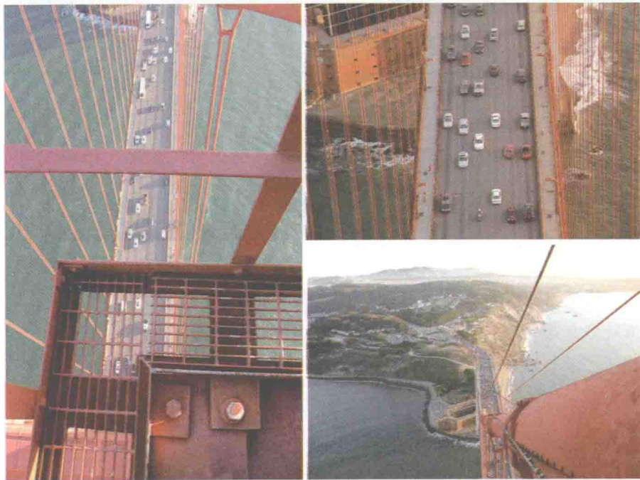
◇ 从塔顶俯瞰桥面
