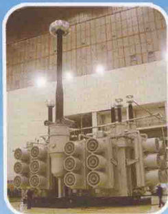
我国第一条1000kV级输电线路晋东南-荆门示范工程， 长治1000kV变电站ODFPS- 1000MVA/1000kV单相自耦变压器
