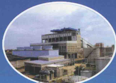
印度尼西亚2 × 15MW电站交钥匙工程
