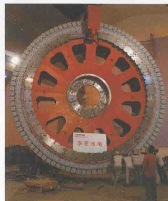
清水塘电站转子现场吊装
