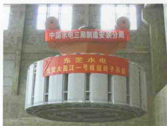
大盈江电站转子现场吊装
