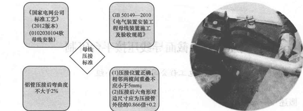
图3 母线压接的规范和要求
