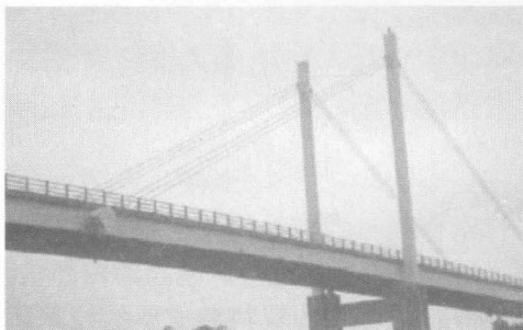
图 1.1-2 位于阿拉斯加的锡特卡海港大桥 (美国最古老的斜拉桥)
