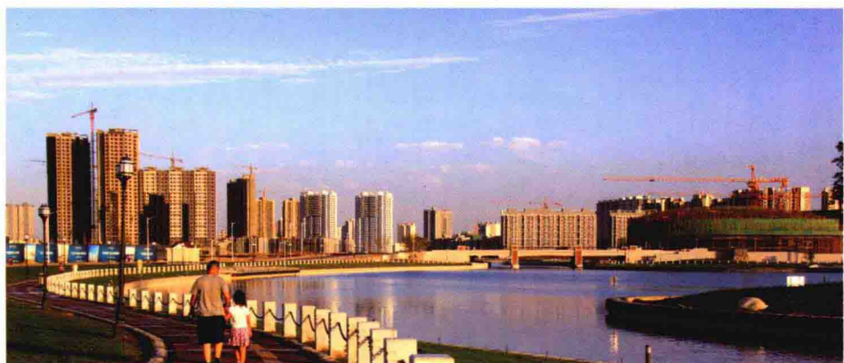
❖ “三河贯通”棚户区改造工程实景
