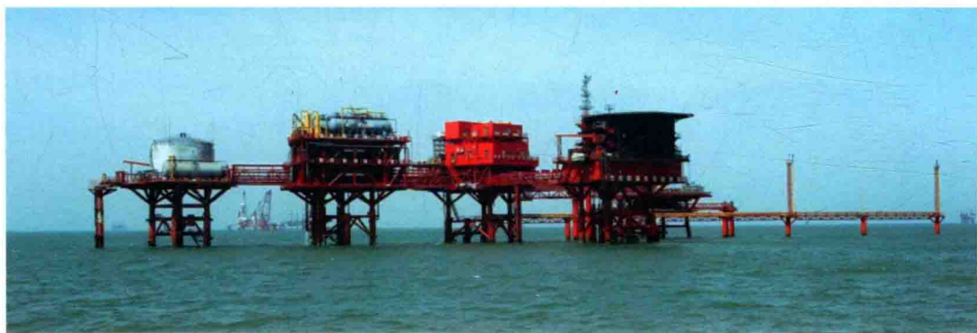
埕岛油田中心二号平台
