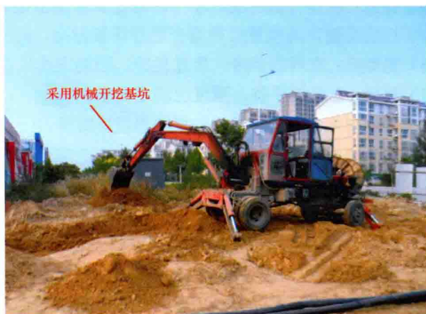
图 1-3 机械开挖基坑
