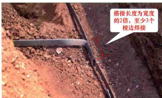
图 1-4 接地体焊接（扁钢搭接）
