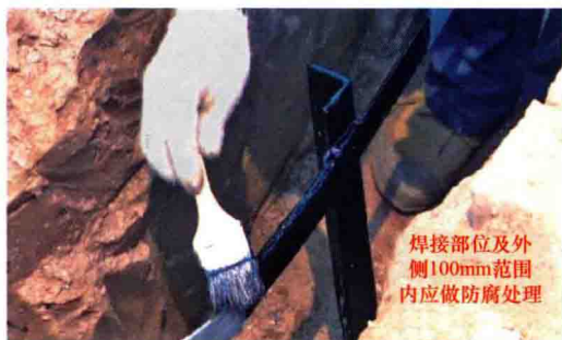
图 1-5 接地体防腐处理
